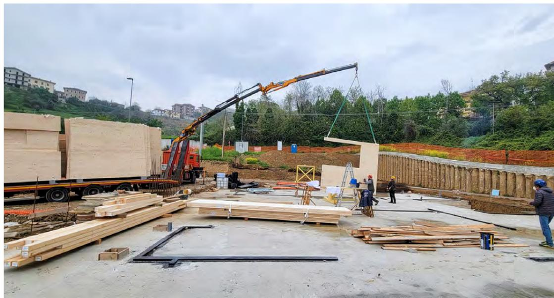
Sopra, il rivestimento in elementi prefabbricati delle paratie di contenimento del terreno e fase di posa dei pannelli in legno X-Lam. In basso, l'assemblaggio dei pannelli in legno delle pareti che, all'interno, sono in cartongesso
